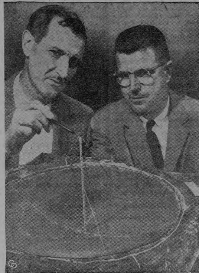
EL MAYOR RADAR DEL MUNDO PARA PUERTO RICO.— William E. Gordon y William McGuire, profesores asociados de ingeniería de la Universidad Cornell, muestran un modelo del mayor radar del mundo. Los dos diseñaron la maquinaria electrónica y supervigilarán su construcción para la Fuerza Aérea de los Estados Unidos, en Puerto Rico. La antena del radar tendrá un diámetro de 1.000 pies, lo que representa tres veces el tamaño de un terreno regular de fútbol.
